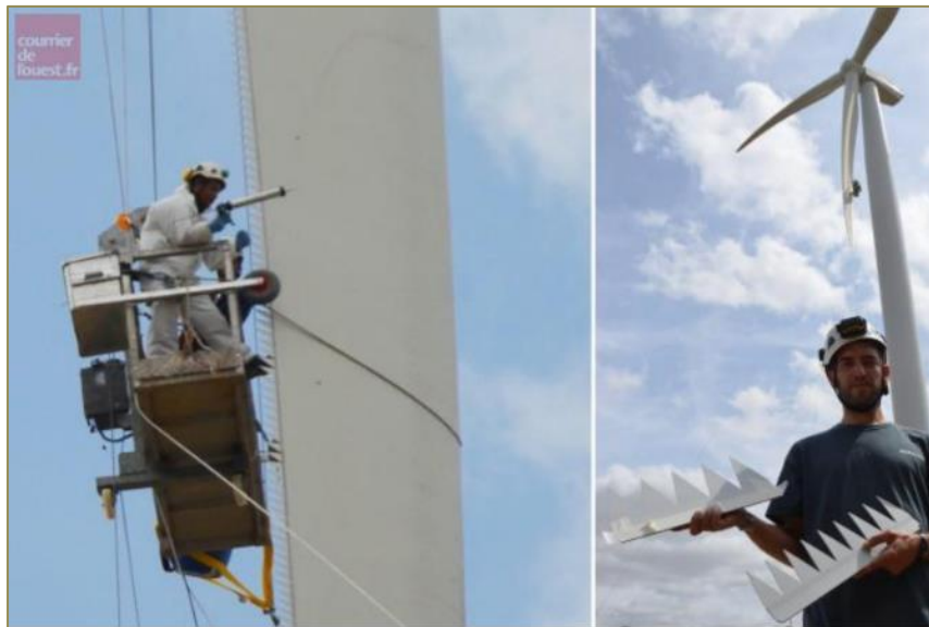
Figure 4 : Installation de serrations sur le parc éolien de Boralex de Coulonges, le courrier de l'ouest, 2016
